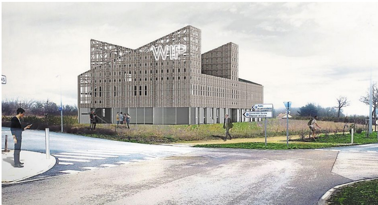
Le bâtiment de coworking devrait ouvrir au public au cours de l'été. La « troisième peau » en bois est ajourée, pour laisser entrer la lumière naturelle.
