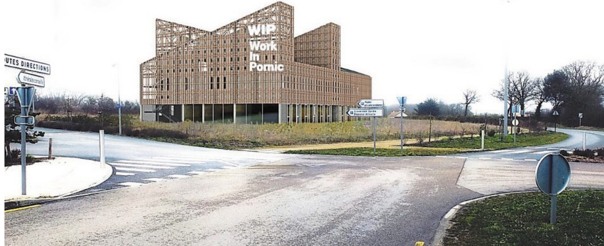
Le toit de la pépinière d'entreprises sera recouvert de panneaux photovoltaïques.
